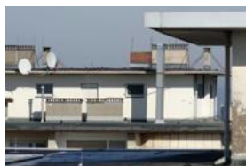
Le câble d'alimentation sur le toit
